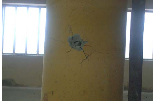
Fig. 8 Inyección de material expansivo para derrocamiento de columnas.
