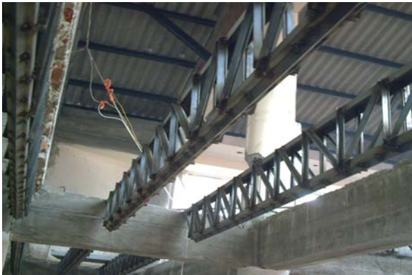
Fig. 3 Reforzamiento del sistema de piso.
