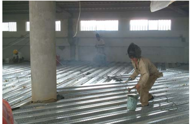
Fig. 4 Colocación placa colaborante.
