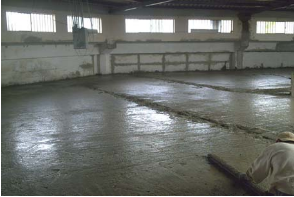
Fig. 7 Terminado de losa de concreto.
