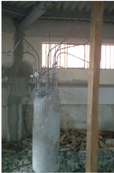
Fig. 9 Derrocamiento de columnas.
