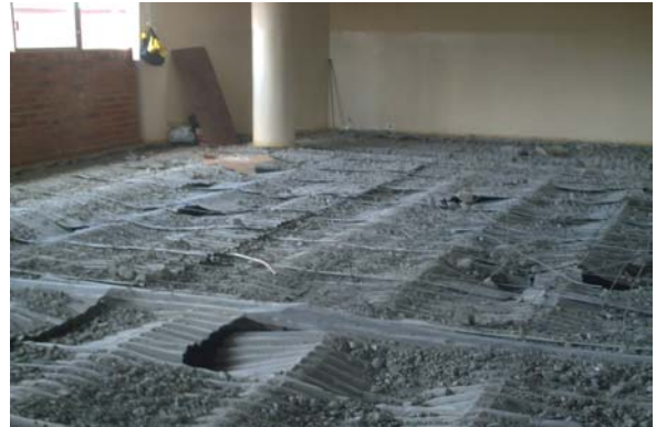
Fig. 2 Derrocamiento del piso existente.
