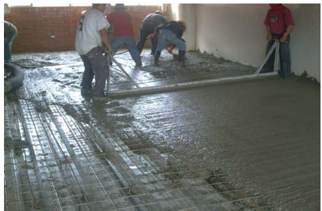
Fig. 4 Colocación placa colaborante.
