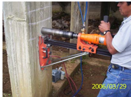
Fig. 4 Extracción de núcleos.
