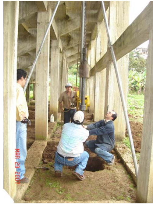
Fig. 6 Ensayo de Penetración SPT.
