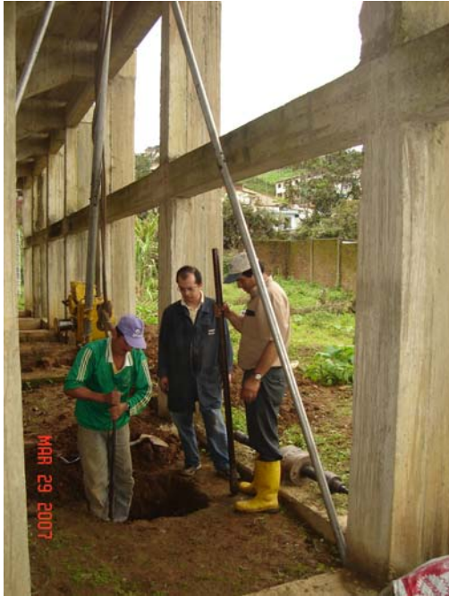
Fig. 5 Perforación para SPT.
