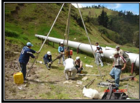
Figura 3: Ensayo SPT (paralelo a la tubería)
