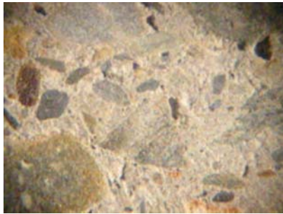
a) Hormigón curado con agua.
